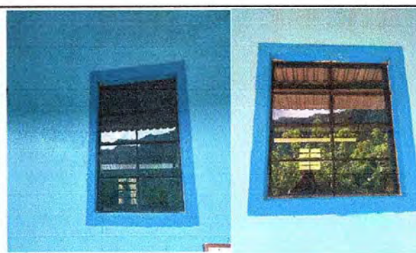
Foto 4: Ventanas de marcos metálicas con vidrios.
