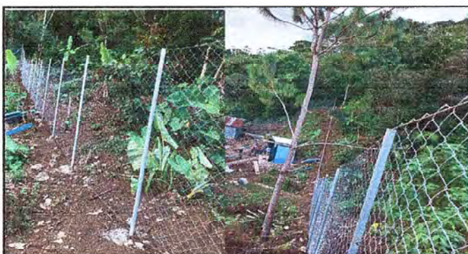
Foto 3: Vista de la malla tensada con varillas de fierros en el suelo y en la parte alta de los tubos.
