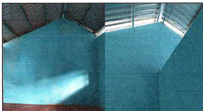
Foto 3: Vista interior de la pintura, estructura de techo y cubierta de lámina.
