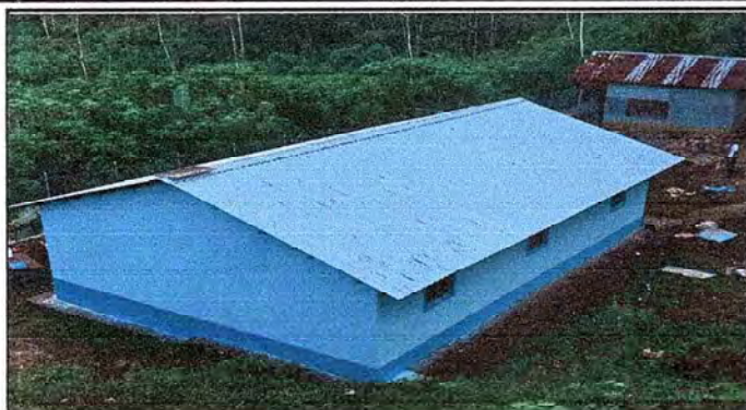
Foto1: Vista panorámica de la cubierta de lámina culminada.
