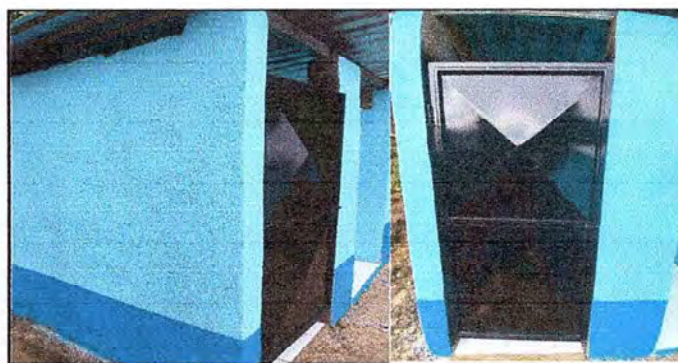
Foto 6: Puertas de los 2 módulos del sanitario.
