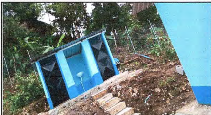
Foto 1: Vista panorámica de los sanitarios, pintura, puertas, gradas de acceso de los baños.
